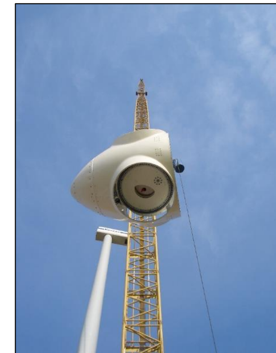
Assemblage du rotor
