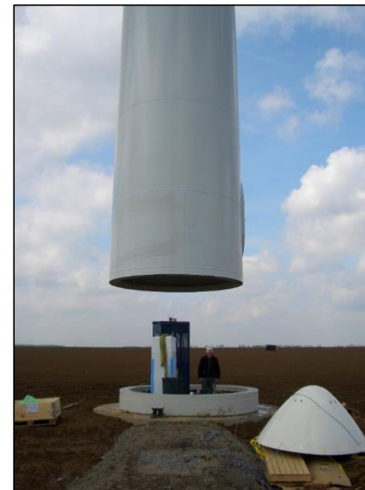
Montage de la base du mât
