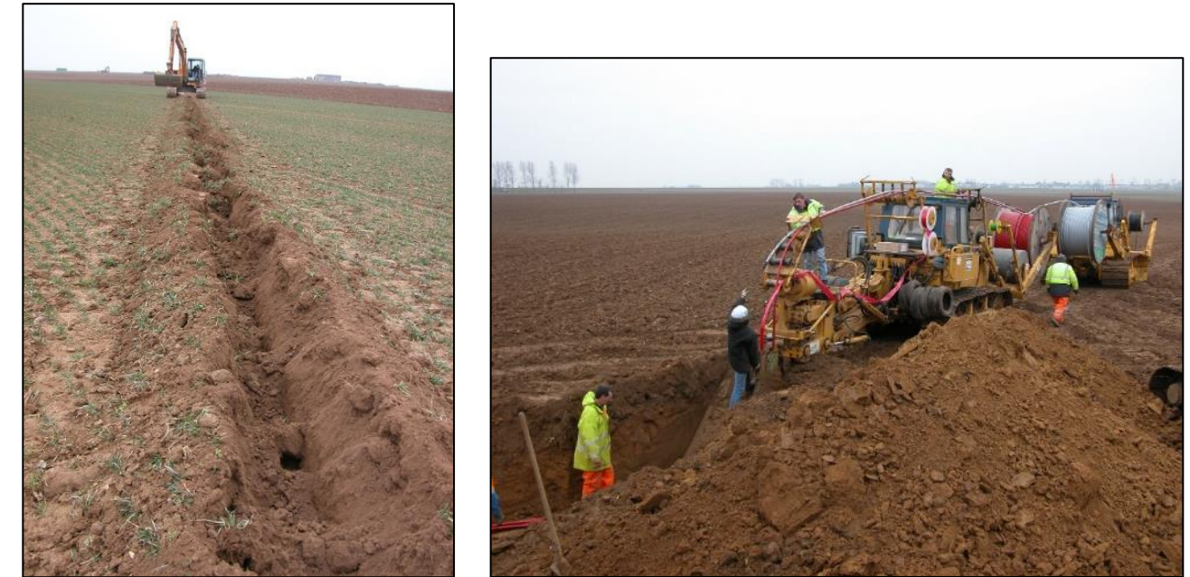
Figure 32 : Photographies d'une opération de raccordement (Source : EOLISE)
