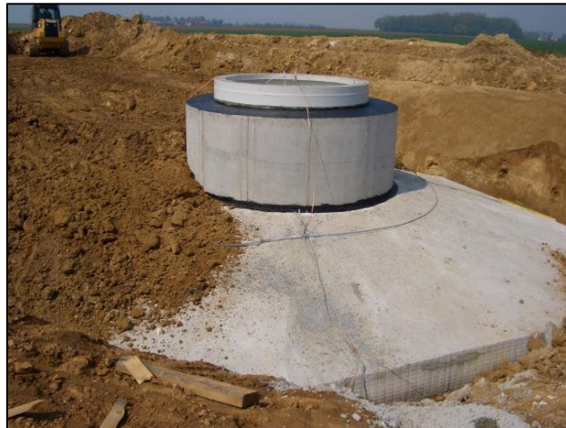
Figure 30 : Remblaiement des fondations (Source : EOLISE)
