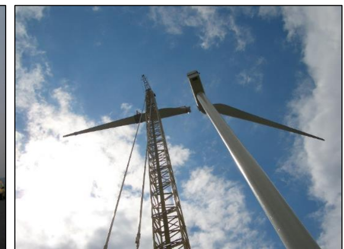
Assemblage des pales
