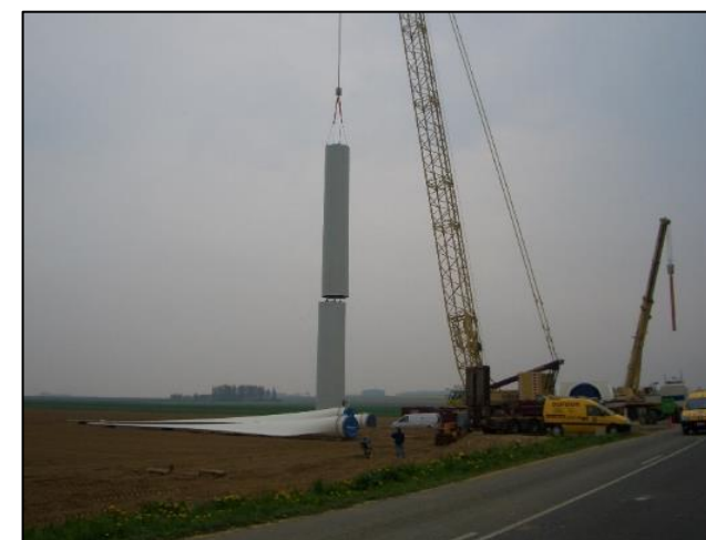
Assemblage des tronçons du mât
