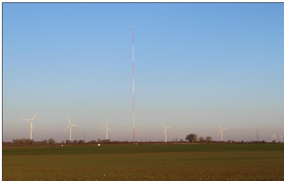
Figure 23 : Mât de mesures anémométriques du projet de la Plaine de Balusson (Crédit photo : EOLISE, janvier 2020)
